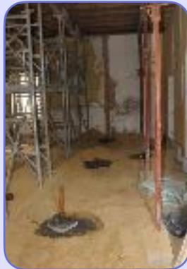
. **début septembre** pour respecter les temps de séchage des différents bétons...et les congés des entreprises, les étalements provisoires sont démontés.
